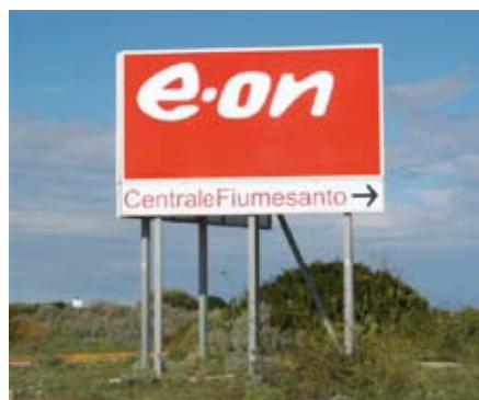
La centrale E.ON di Fiumesanto
